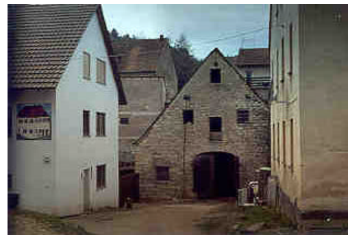
Neubauten neben stark substanzgefährdeten historischen Nebengebäuden
